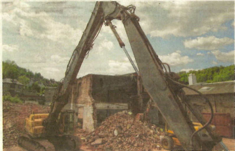
Die Abrissbagger haben die Regie auf dem Firmengelände übernommen. Das älteste Fabrikgebäude der Firma aus dem Jahr 1810 fällt. Boecker und Wender Stahl will hier weiter investieren. FOTO: MARCEL KROMBUSCH
