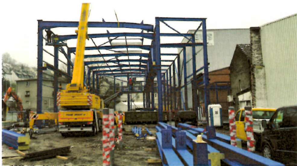
Die neue Produktionshalle wird errichtet.
